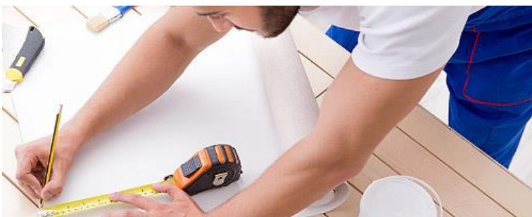
Строительные работы и ремонт помещений
